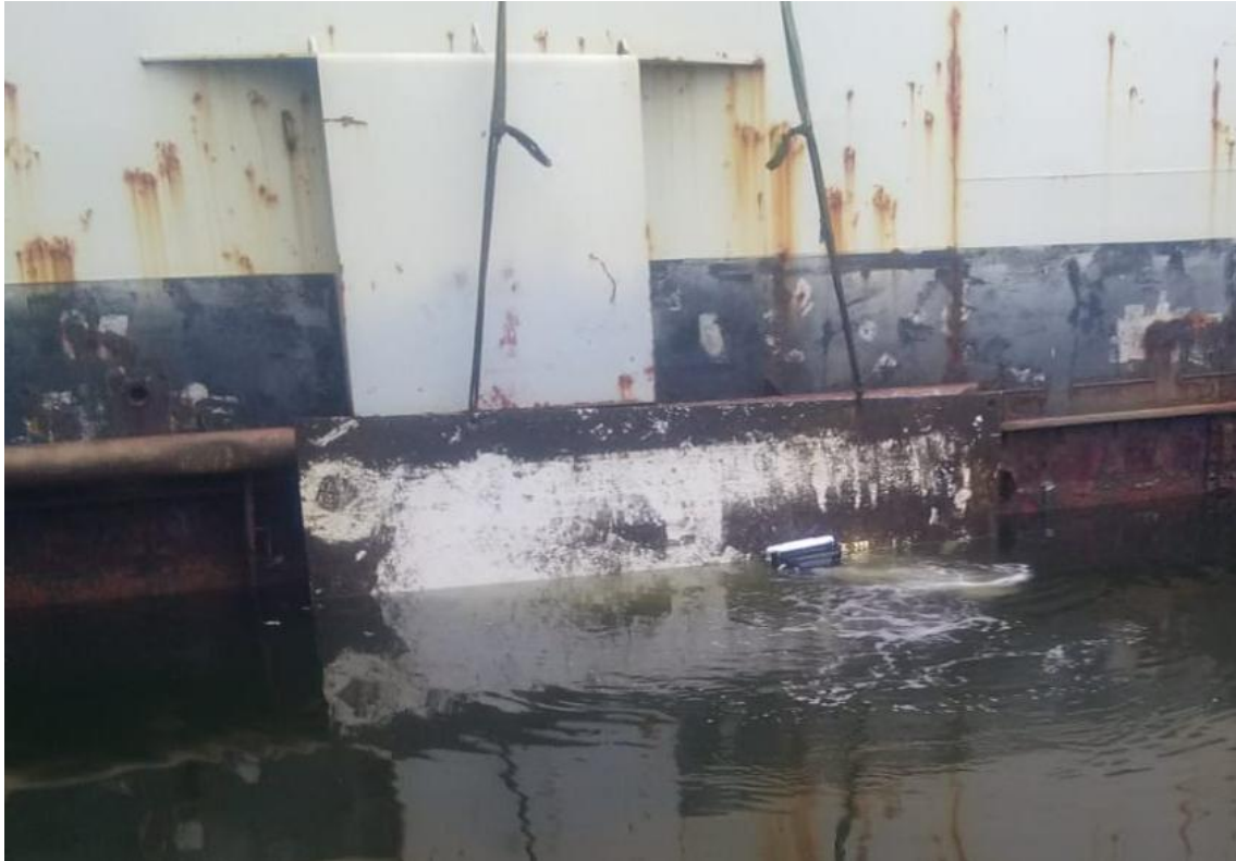
Abb. 44: KeelCrab bei der Reinigung der Stahlplatte, November 2019
