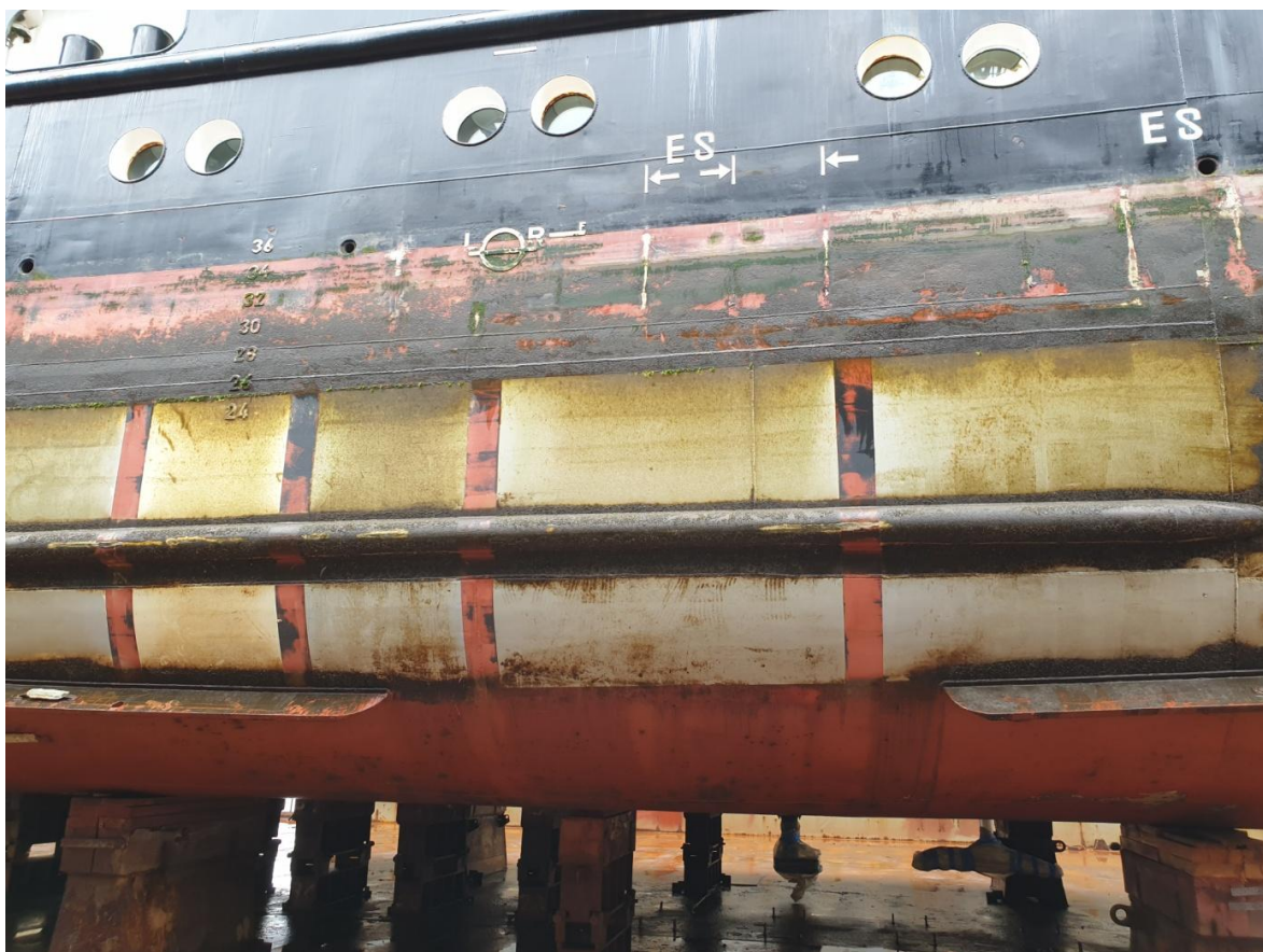
Abb. 30: Antihaft-Beschichtungen auf der „WEGA“ nach Unterwasserreinigung Juli 2019
